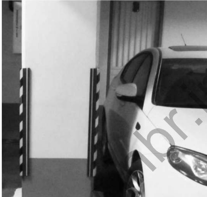
شکل ۲۳-۴-۵ ضربه گیر سرستون
