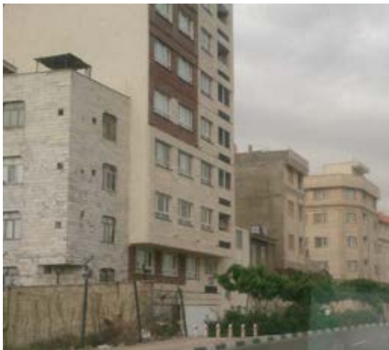
تصویر ۷۱- نماسازی نمای جانبی با حداقل اقدام و بدون توجه به نمای اصلی
