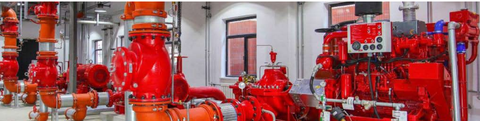
شکل ۴- شیرآلات و متعلقات zone control valve
