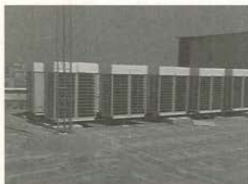
ملازده ۹ دستگاه یونیت بیرونی هر یک به ظرفیت ۱۰۰,۰۰۰ بی تی یو ۳۰۰۰ متر زیر بنا
