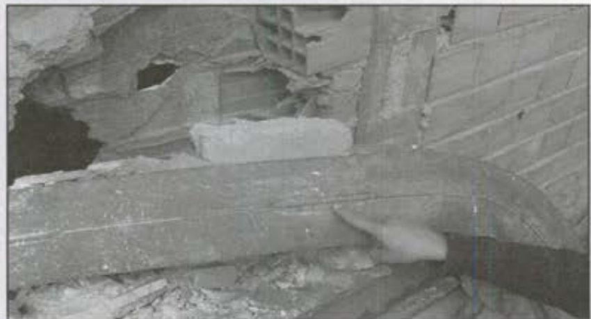
تصویر شماره ۱۲: برش جوش ستون در کمانش ستون
