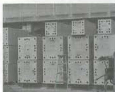
شکل ۴: ستون‌های پیش ساخته دیو شده در کارگاه
