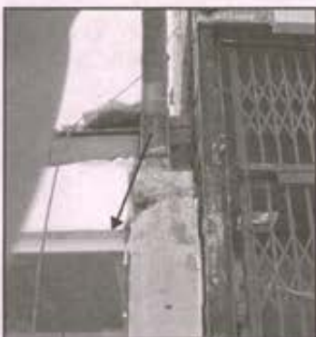
تصویر شماره ۱۶: رها شدن کنسول از محل جوش ناقص نبش زیر سری
