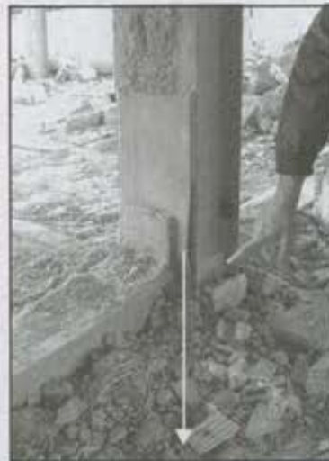
تصویر شماره ۲۴: کماتش موضعی و عدم رعایت طول جوش کافی
