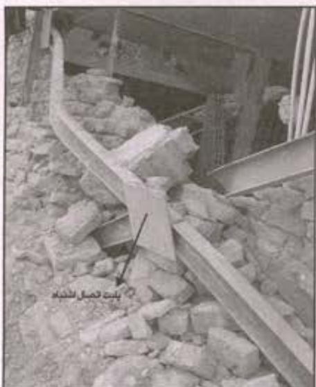
تصویر شماره ۲۰: نمایش عملکرد کشش و فشار در بادبند
