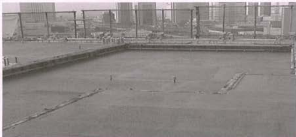
شکل ۷: مراحل بتن ریزی دیافراگم با اختلاف تراز ۳۰ سانتی متر
