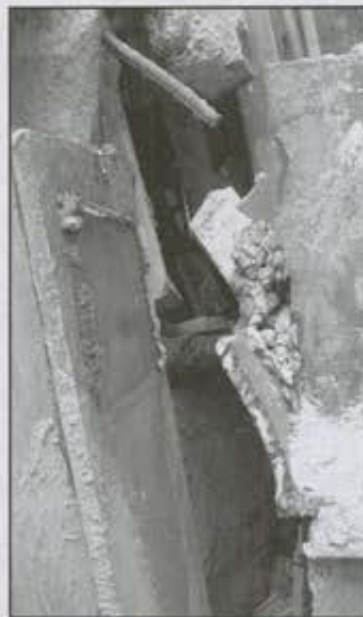
تصویر شماره ۱۳: مقطع بریده سده اتصال نیشی بالای تیر
