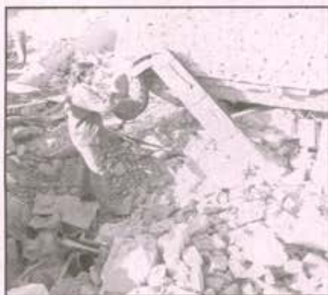
تصویر شماره ۶: تشکیل مفصل پلاستیک در ستون
