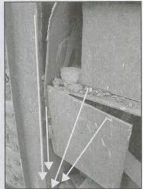
تصویر شماره ۲۳: عدم رعایت طول جوش کافی و نقص جوش
