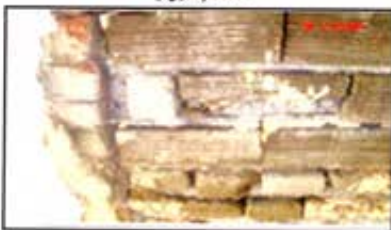
شکل ۱۳ ب: پر کردن بازشو جهت دستیابی به تراکم مناسب دیوار [۵]
