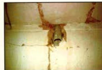
شکل ۸: ایجاد انفصال در دیوار با عبور لوله از داخل دیوار [۲]
