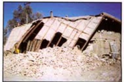
شکل ۲: آسیب ناشی از پایین بودن کیفیت چسبندگی ملات [۱]
