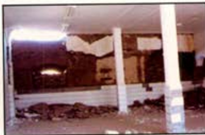
شکل ۱: آسیب ناشی از پایین بودن کیفیت واحدهای بنایی [۲]
