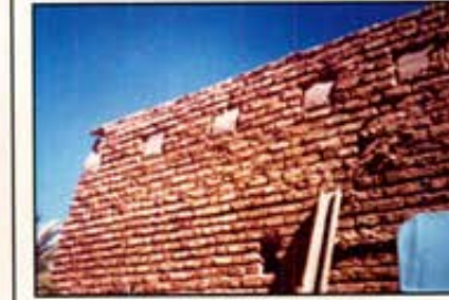
شکل ۷-الف: قرار داشتن مستقیم تیرهای دال روی دیوار [۲]
