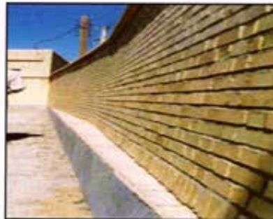
شکل ۴-الف: عدم کنترل طول آزاد
