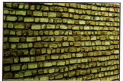
شکل ۳: خالی بودن درزهای قائم بین واحدهای بنایی از ملات [۱]
