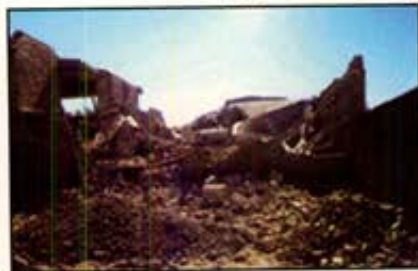
شکل ۱: آسیب ناشی از پایین بودن کیفیت واحدهای بنایی [۲]
