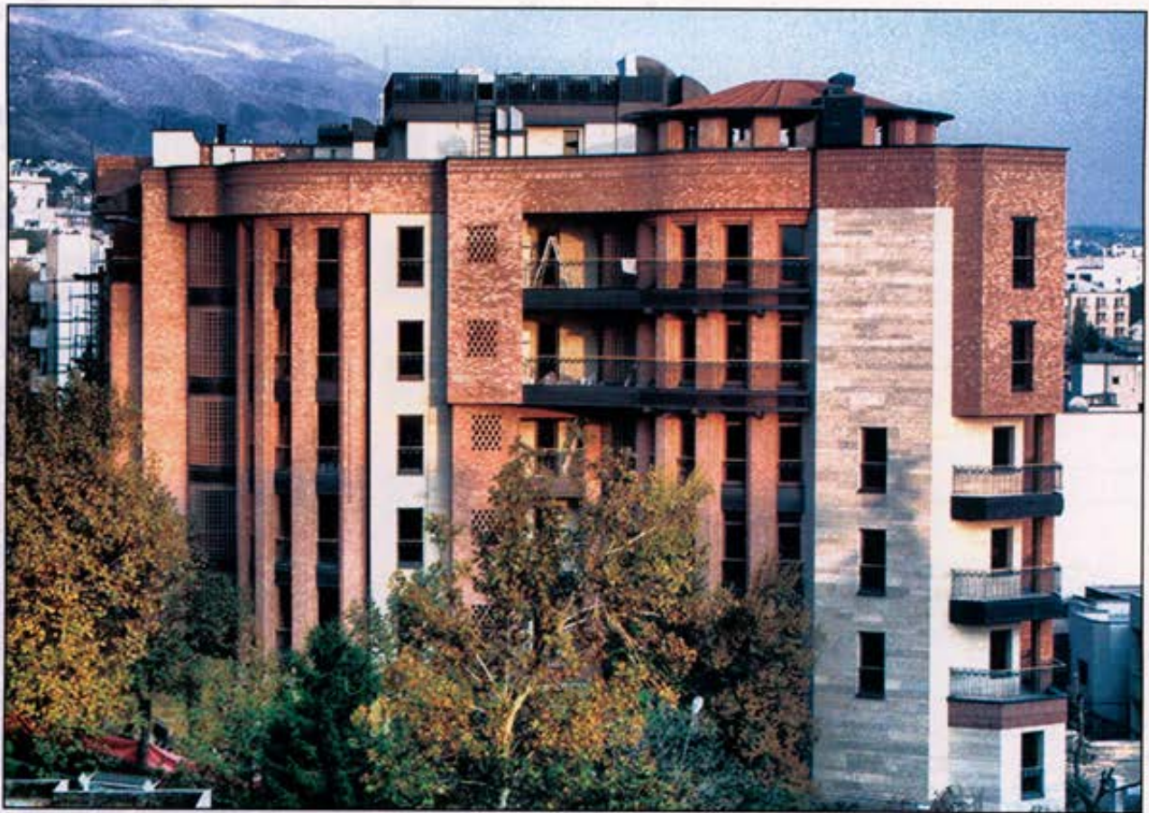
تصویر ۱: ساختمان مسکونی یاسر / طراح: مهندس محمدرضا نیکبخت
