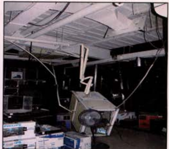
شکل ۱: الف) عملکرد نامناسب سیستم تاسیسات مکانیکی - زلزله ۱۹۹۴ نورث ریج. شکل ۱: ب) شکستگی لوله آبفشان در بیمارستان Olive View زلزله ۲۰۱۰ شیلی
