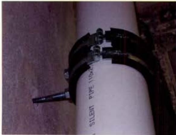
شکل ۴: بست های نگهدارنده سیستم لوله کشی بی صدا
