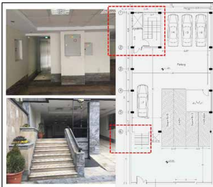
▲ تصویر ۲- پله در مسیر خروج ساختمان و کم عرض بودن مسیر
