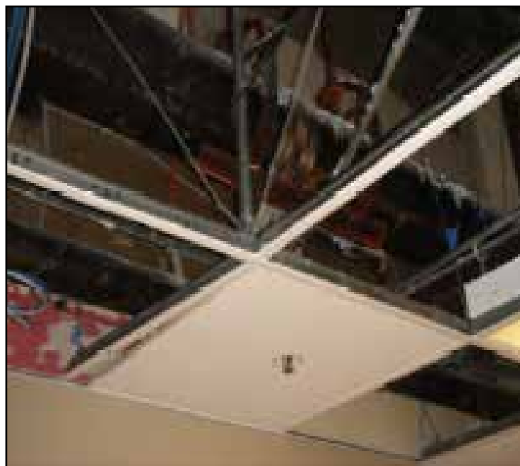
▲ تصویر ۸- نصب افشانگر در سقف ها
