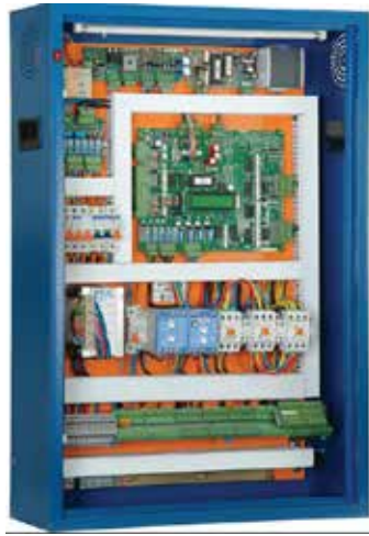
شکل ۱-۳: تابلو فرمان آسانسور دو سرعته
