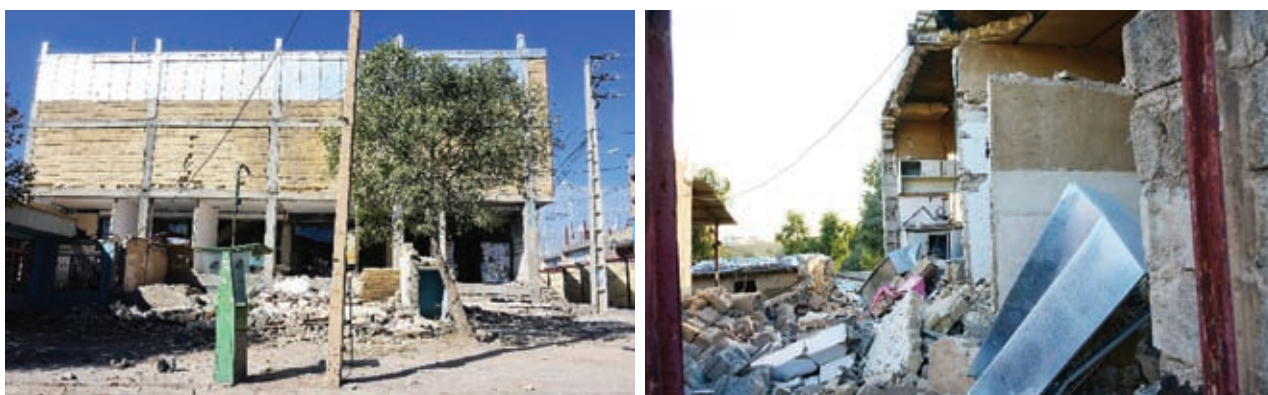
شکل ۲۶: تخریب در شهر تازه‌آباد
