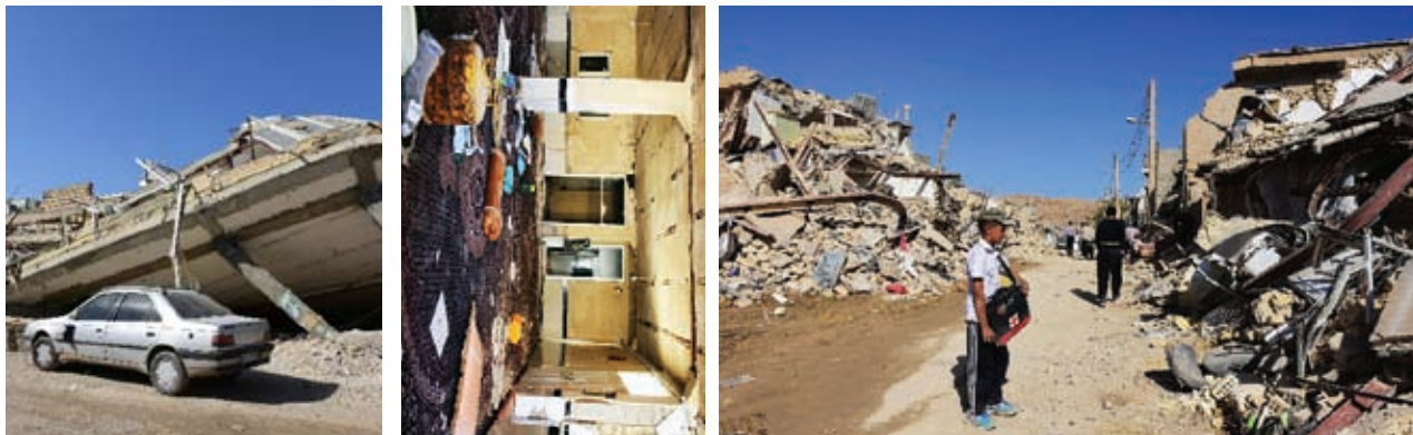
شکل ۲۲: تخریب محله فولادی سرپل ذهاب
