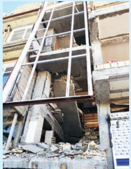
شکل ۴-۱۰- خرابی راه پله‌ها، مشارکت در باربری جانبی و شکل پذیری نامناسب
