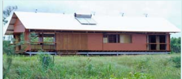
شکل ۵ - چوب و فلزروی داربست (خانه ماریکا در الدرتون) (هالاس، ۱۳۶۵: ۸۰)
