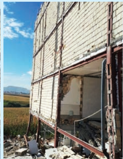
شکل ۵-۴- ضعف در اعضای بادبندها و اتصالات آن
