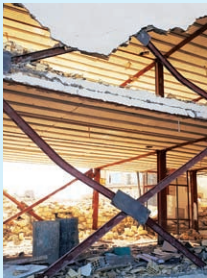
شکل ۵-۴- ضعف در اعضای بادبندها و اتصالات آن
