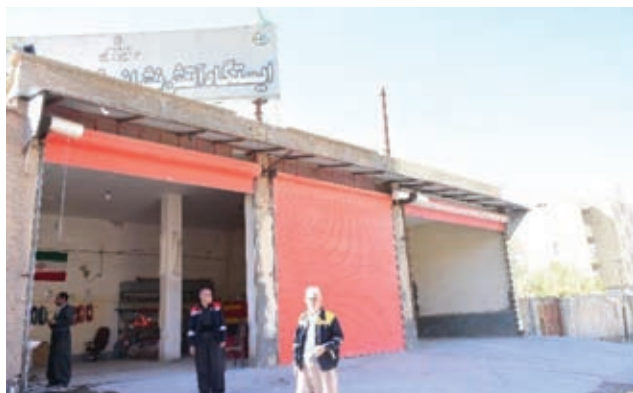
شکل ۲۱: ایستگاه آتش‌نشانی - تازه‌آباد
