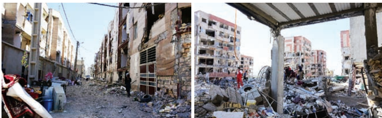
شکل ۲۳ و ۲۴: تخریب مسکن مهر سرپل ذهاب
