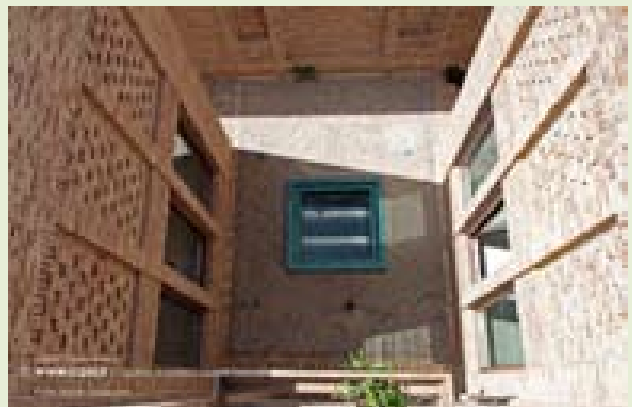
شکل ۱۲- نمای جنوب غربی
