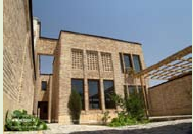
شکل ۱۱- نمای جنوب غربی
