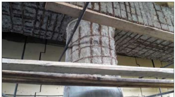
شکل ۱- یکی از پلهای تهران که میلگردهای فولادی آن بر اثر خوردگی ناشی از بکار بردن نمک جهت یخ زدایی در فصل زمستان بدین صورت درآمده است
