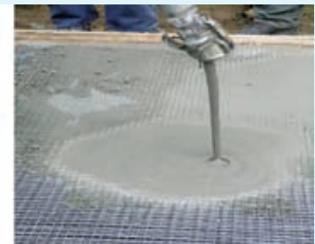
تصویر ۲- ریختن بتن بر روی شبکه فولادی تصویر ۳- پمپ کردن بتن بر روی میکروتقویت فولادی ماخذ: Hafmann, P, 2011, 12
