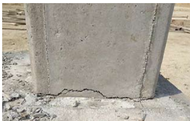
تصویر ۸- ترک های افقی ناشی از قالب زدگی و اصلاح شاغولی بعد از گیرش اولیه بتن ستون
