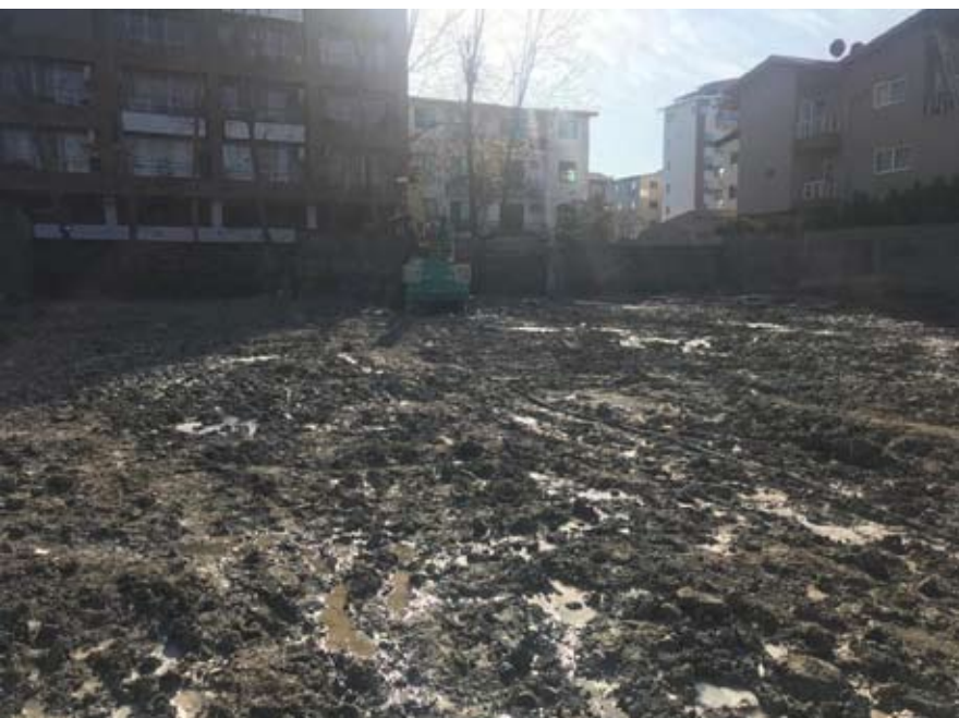
تصویر شماره ۱: تصویری از گود پروژه
