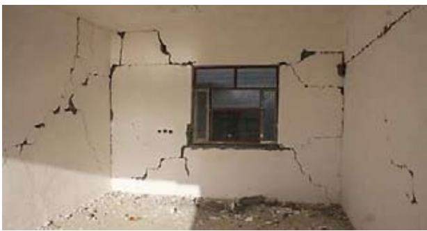
تصویر ۱۶- ترک‌های ضربدردی ناشی از دریافت طبقات در حرکت‌های رفت و برگشتی زلزله در اطراف بازشو
