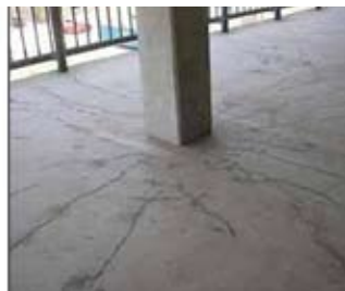
تصویر ۲۰- ترک های شعاعی خمشی اطراف تکیه گاه روی دال های بتنی
