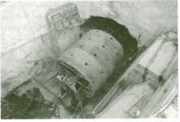
تونل انحراف آب سد کارون ۳
