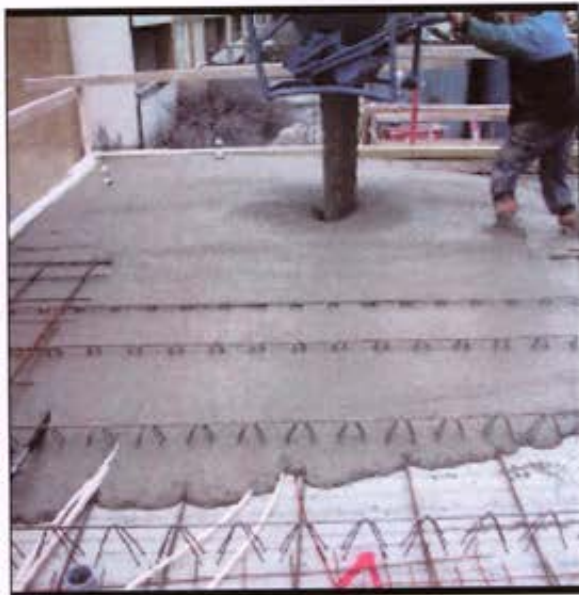
شکل (۱): روانی و قابلیت جریان بتن خودتراکم در پایان کار بدون استفاده از ویریه
