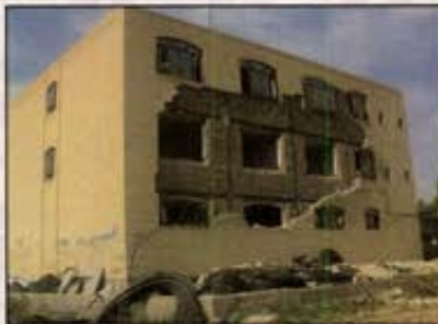
دری قوی تر از دیوار!!! جداشدگی و ریزش نمابه علت نداشتن اتصال کافی - تکرار نمونه های بیم
