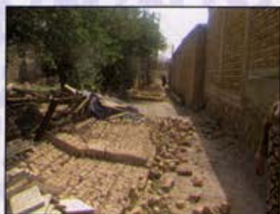
انهدام کامل ساختمان‌های خشت و گلی - سقوط جانبی دیوارهای آجری
