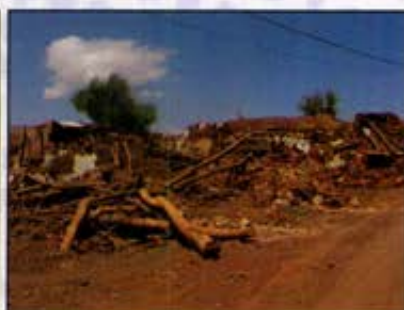
انهدام کامل ساختمان‌های خشت و گلی - سقوط جانبی دیوارهای آجری
