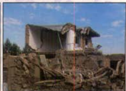
فقدان شناره های قائم و افقی و اتصال سقف و دیوار
