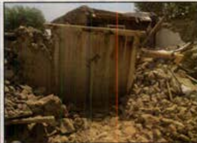
دری قوی تر از دیوار!!! جداشدگی و ریزش نمابه علت نداشتن اتصال کافی - تکرار نمونه های بیم
