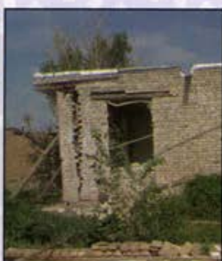
جدا شدن دیوار به علت نداشتن کلاف قائم
