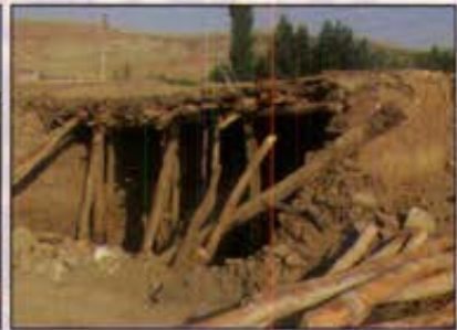
ساختمان خشتی با انسجام نسبی سقف - تخریب وسیع در ساختمان های مختلف
