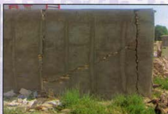
جدا شدن دیوار به علت نداشتن کلاف قائم
