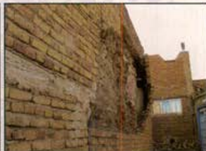
استفاده از نما (روکش) آجری برای ساختمان خشتی سقوط تاق (سایه بان) بالای درب
