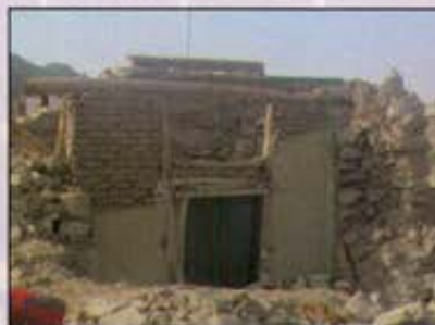
تخریب صد درصدی روستا - خانه های خشت و گلی درس های ناگفته از ایستایی یک در با انسجام یک قاب ساده
