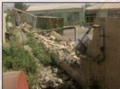
شکست و ریزش دیوار داخلی سقوط دیوار و ایجاد خطر برای تاسیسات گاز خانگی
