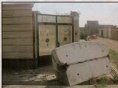
استفاده از نما (روکش) آجری برای ساختمان خشتی سقوط تاق (سایه بان) بالای درب
