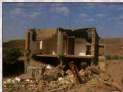
فقدان شناره های قائم و افقی و اتصال سقف و دیوار
