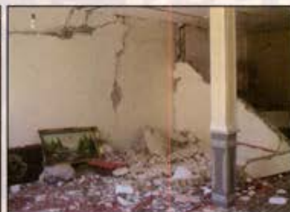
شکست و ریزش دیوار داخلی سقوط دیوار و ایجاد خطر برای تاسیسات گاز خانگی
