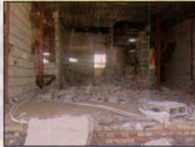
شکست خرج از صفحه دیوار خارجی و ریزش دیوار داخلی در اثر فقدان اتصال لازم
