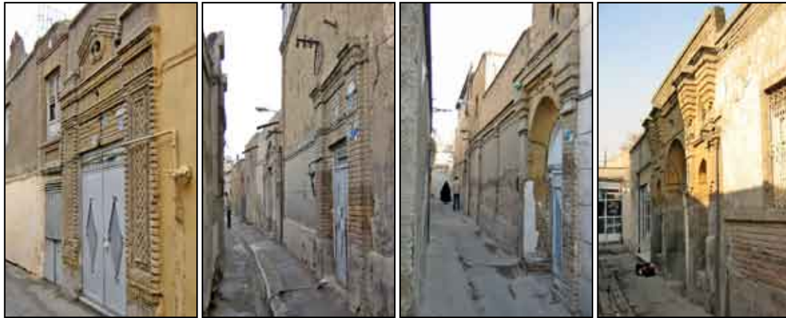
تصویر ۳) نمونه‌ای از سردرهای موجود خانه‌های مسکونی
