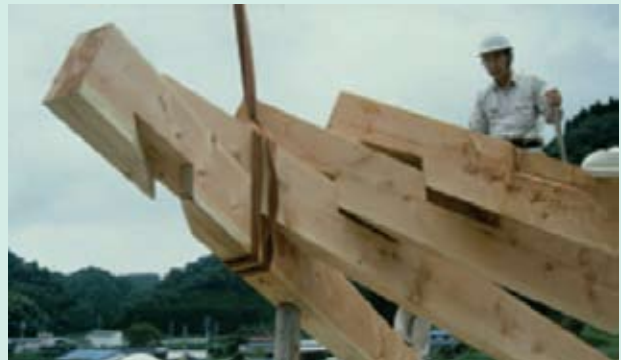
شکل (۱۶) اتصال کام و زبانه [۲]
