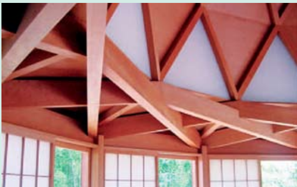
شکل (۲۲) سازه بستاروند بکار رفته در سقف خانه سنتی ژاپنی
