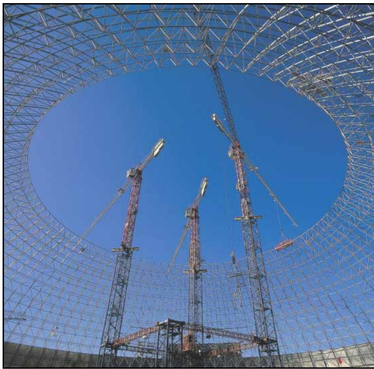
▲ شکل ۸: در حال ساخت Glob Arena
