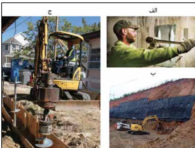
▲ شکل ۳- نصب اعضای مارپیچ، الف) به شکل دستی، ب) با استفاده از بیل مکانیکی ج) با استفاده از بیل کوچک [۶]
