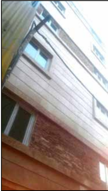
▲ استفاده از مصالحی مثل سنگ بادر و سنگ قیچی که ابعاد کوچکی دارند؛ امکان اسکوپ نداشتنه و در صورت انجام پیچ و رول پلاک نیز می شکنند.
