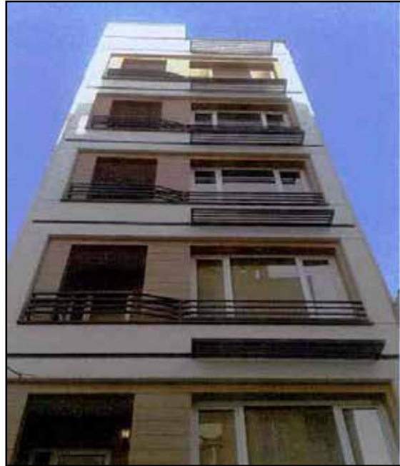
▲ اجرای نما با استفاده از ورق های سیمانی (Cement Bord) و (Deco Bord) با توجه به اینکه ورق های سمنت بورد مستقیم به زیرسازی فلزی نصب شده و به دلیل متغیر بودن ضریب الاستیسیته این دو باعث اعوجاج در نما و باز شدن درز بین دو ورق و در نهایت موجب نفوذ آب به پشت نما می شود که فاقد عایق رطوبت است.
