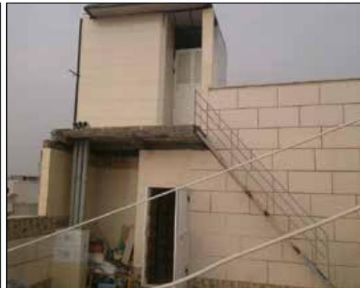
▲ اجرای نما با استفاده از ورق های سیمانی (Cement Bord) و (Deco Bord) با توجه به اینکه ورق های سمنت بورد مستقیم به زیرسازی فلزی نصب شده و به دلیل متغیر بودن ضریب الاستیسیته این دو باعث اعوجاج در نما و باز شدن درز بین دو ورق و در نهایت موجب نفوذ آب به پشت نما می شود که فاقد عایق رطوبت است.
