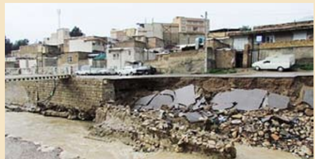
شکل ۲- (الف)، تخریب دیوار حائل و راه کنارگذر رودخانه
