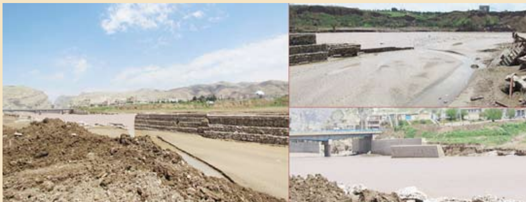
الف) واژگونی و تخریب کامل ساختمان اسکلت فولادی که دلیل اصلی آن گسیختگی در خاک زیر پی بوده است
