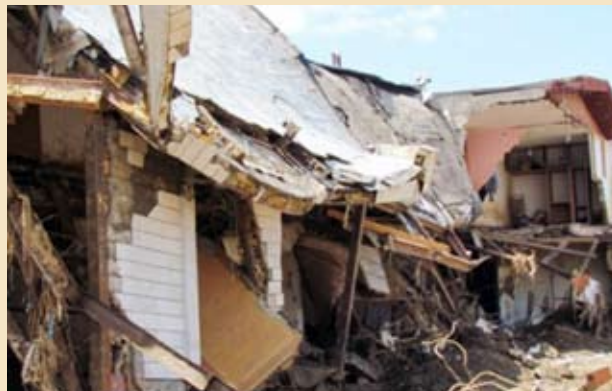
شکل ۴- تخریب ساختمان مسکونی با اسکلت فولادی و سقف های طاق ضربی- پلدختر
