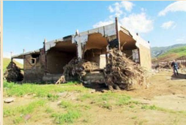
شکل ۸- روستای زورانتل: ساختمان از نوع اسکلت فلزی به همراه مهاربند که دیوارها در اثر شدت سیلاب و آوار ناشی از سیل تخریب شده ولی سیستم سازه‌ای به دلیل انسجام و عملکرد مناسب پایداری خود را حفظ کرده است.
