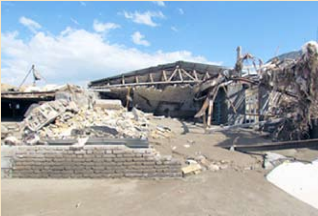
شکل ۹- تخریب کامل ساختمان‌های روستای چم کبود به دلیل شدت سیلاب و عدم رعایت مشخصات فنی در اجرای دیوارهای باربر مصالح سنگی و آجری
