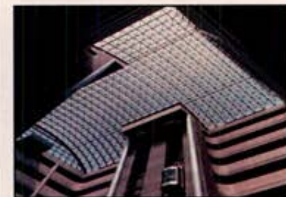
900 m2 translucent vaulted med center
