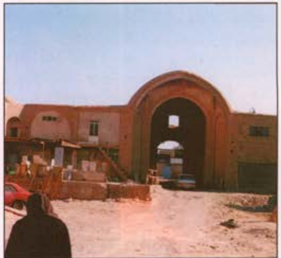
شکل ۵- قسمت‌های تخریب شده در حیاط سرای آقا
