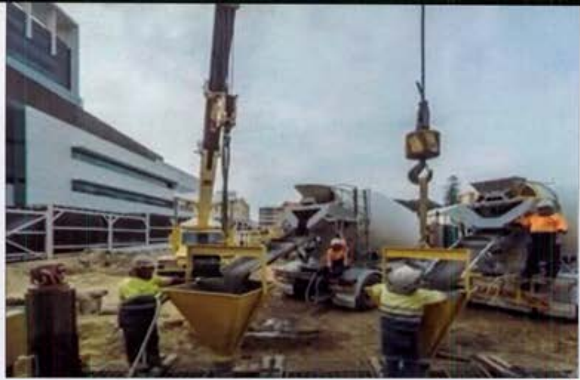
شکل شماره ۴- بتن ریزی دیوارها
