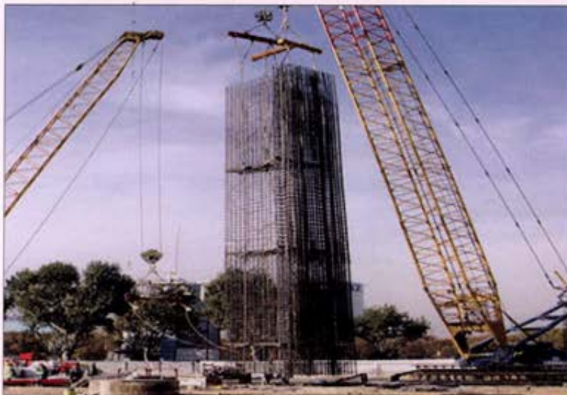
شکل شماره ۲- کارگذاری قفسه آرماتور
