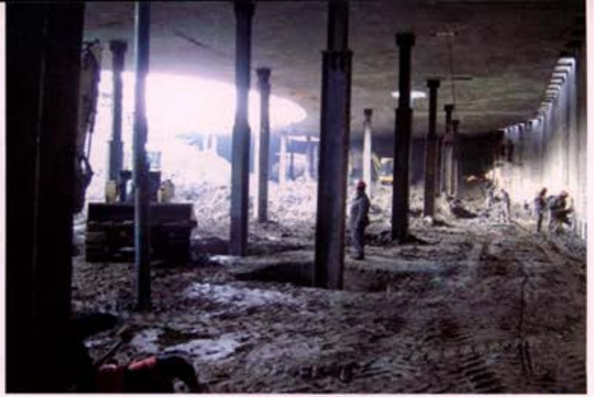
شکل شماره ۷- اجرای سقف اول و خاکبرداری تا تراز بعدی
