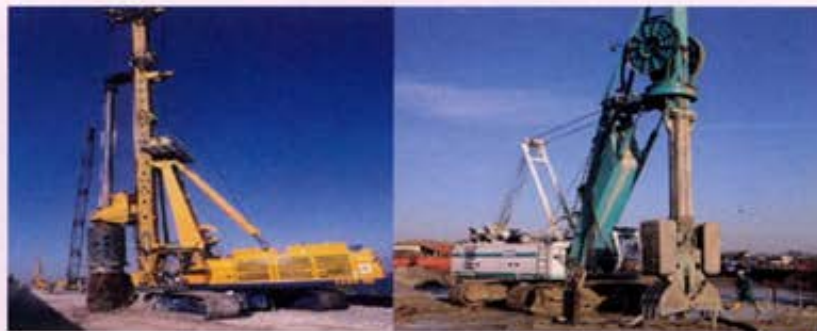
شکل شماره ۱- حفاری با استفاده از دستگاه گراب
