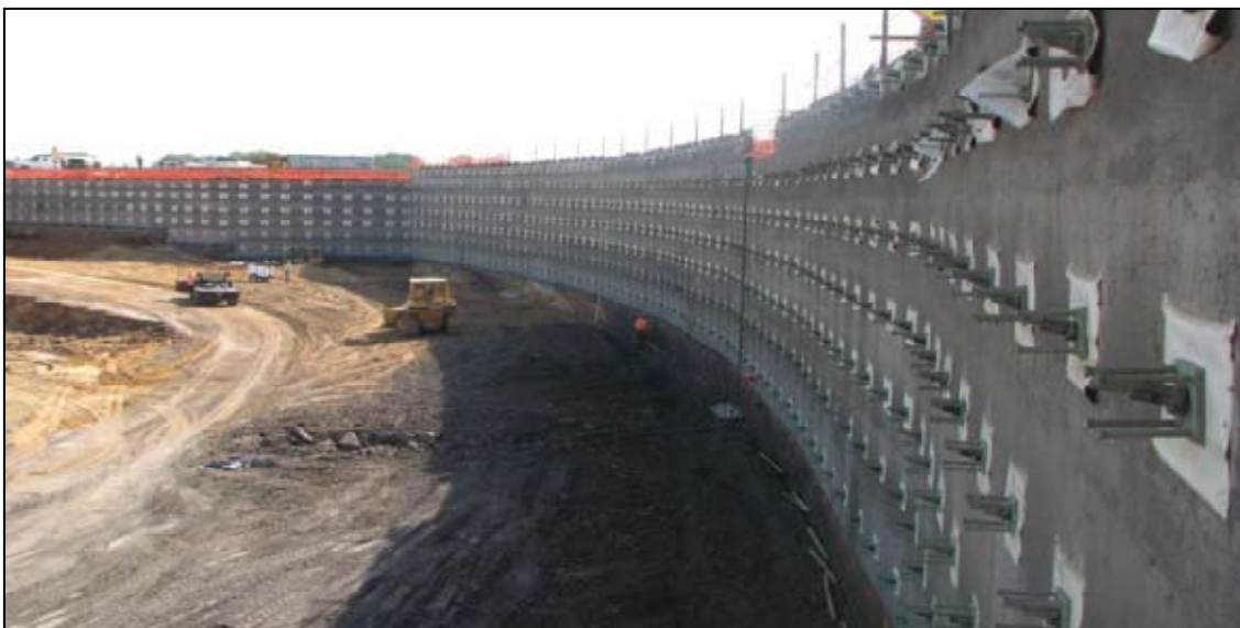
شکل ۱- نمایی از یک گود پایدارشده به روش نیلینگ
