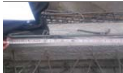
تصویر ۷- عدم رعایت گام مجاز زیگزاگها
