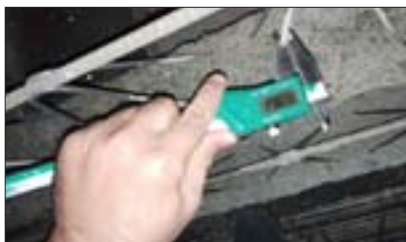
تصویر ۱۲- استفاده از میلگرد غیر فابریک
