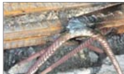
تصویر ۱۰- اتصال خرپای تیرچه با استفاده از جوشکاری با الکتروود دستی
