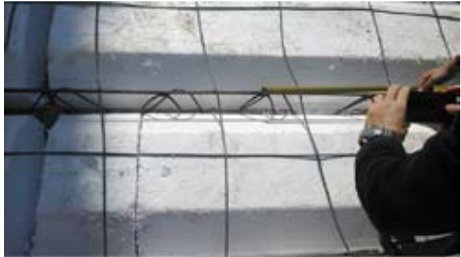
تصویر ۳- عدم رعایت گام مجاز زیگزاگها
