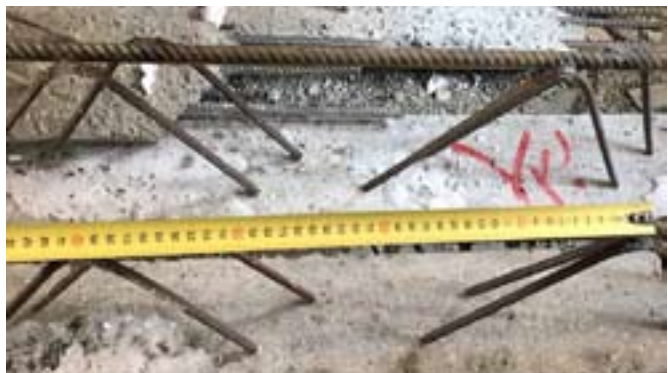
تصویر ۵- عدم رعایت گام مجاز زیگزاگها
