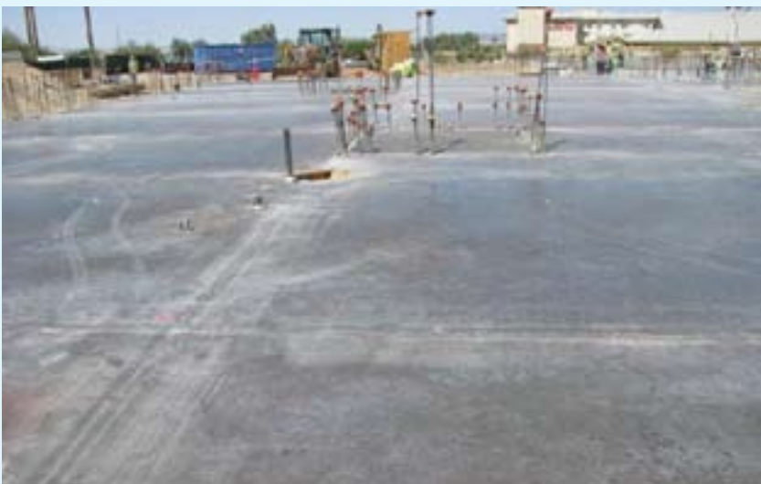
شکل ۵- استفاده از الیاف ماکرو مصنوعی به منظور کنترل ترک‌های حرارتی و جبهه‌شدگی در پروژه دادگاه فدرال یوما
