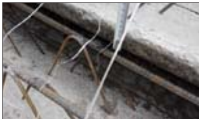
تصویر ۹- اتصال خرپای تیرچه با استفاده از جوشکاری با الکتروود دستی
