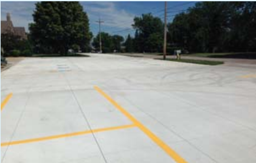
شکل ۴- استفاده از الیاف ماکرو مصنوعی به جای میلگردهای حرارتی در پروژه دانشگاه ایالت اوهاو
