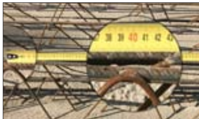
تصویر ۸- عدم رعایت گام مجاز زیگزاگها
