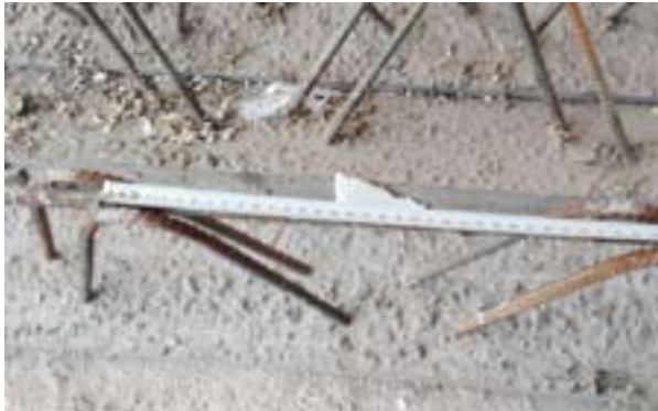
تصویر ۴- عدم رعایت گام مجاز زیگزاگها
