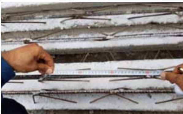
تصویر ۶- عدم رعایت گام مجاز زیگزاگها
