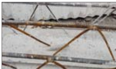
تصویر ۱۱- اتصال خرپای تیرچه با استفاده از جوشکاری با الکتروود دستی
