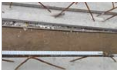
تصویر ۱۴- استفاده از میلگرد غیر فابریک
